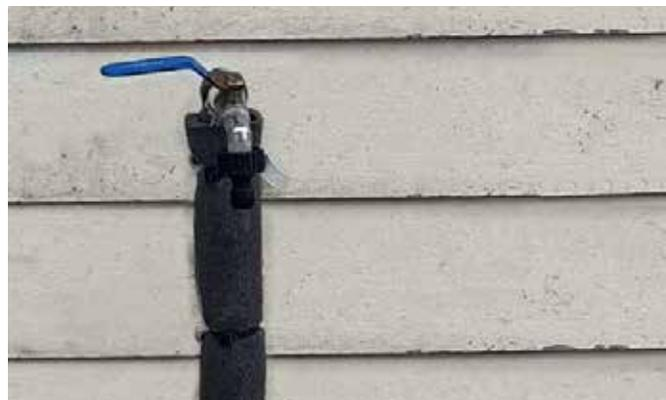
**2. Protege térmicamente las instalaciones domiciliarias** expuestas al frío. Con bajas temperaturas, estos puntos se congelan y conducen el hielo hacia el interior de las instalaciones.
