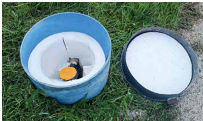
**1. Protege tu medidor** con un nicho y tapa con material aislante adecuado como, por ejemplo, plumavit.
